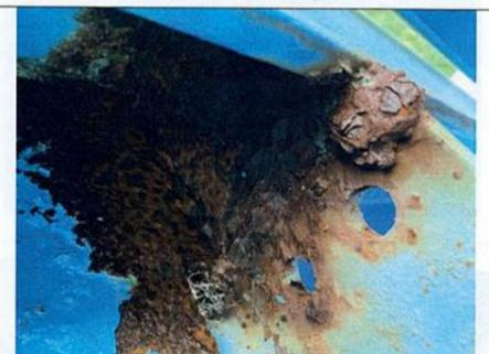
鋼構焊接處生鏽
