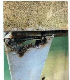
鋼構鏽蝕破裂
