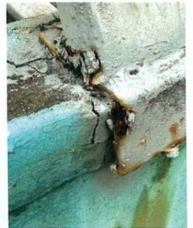
支撐牆體裂痕以及鋼構生鏽
